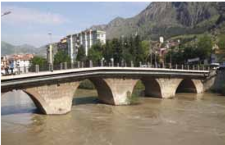
Die Station Brücke
